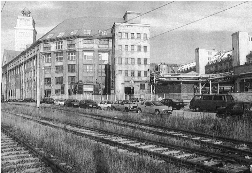
Abb. 2: Der Westflügel - vom Mauerläufer häufig aufgesuchter Bauteil. Foto: SCHONERT
